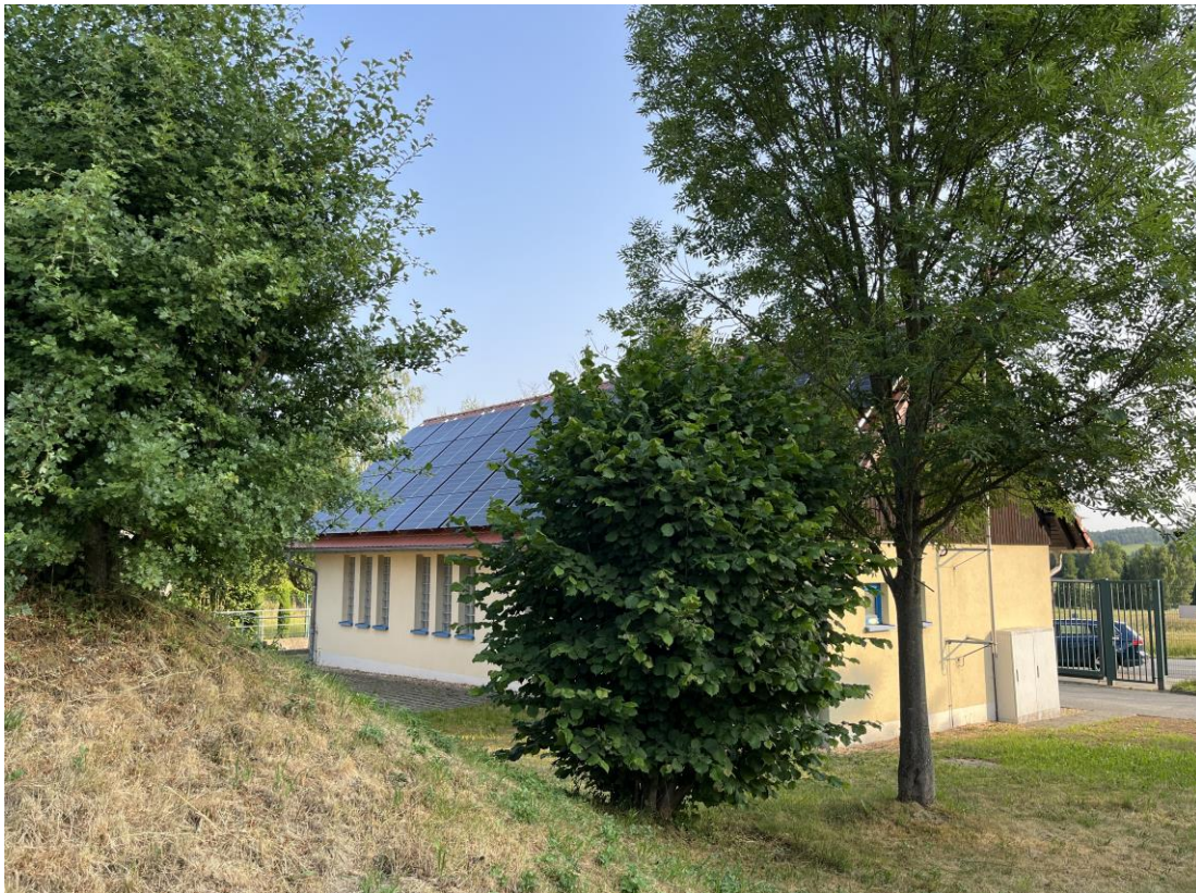
Photovoltaikanlage am Wasserwerk Neusalza-Spremberg
