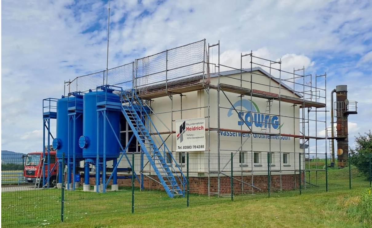
Erneuerung der Innenfilter im Wasserwerk Großhennersdorf
